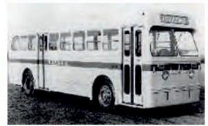
1951 - Leyland Olympic EL40 fabricado por Metropolitan Cammel Weymann - MCW- con caja a palanca. Importado íntegramente de Inglaterra.
