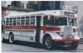
1947 - Super Aclo Regal, carrozado en Uruguay con cabina a la izquierda y caja de cambios con preselección.
